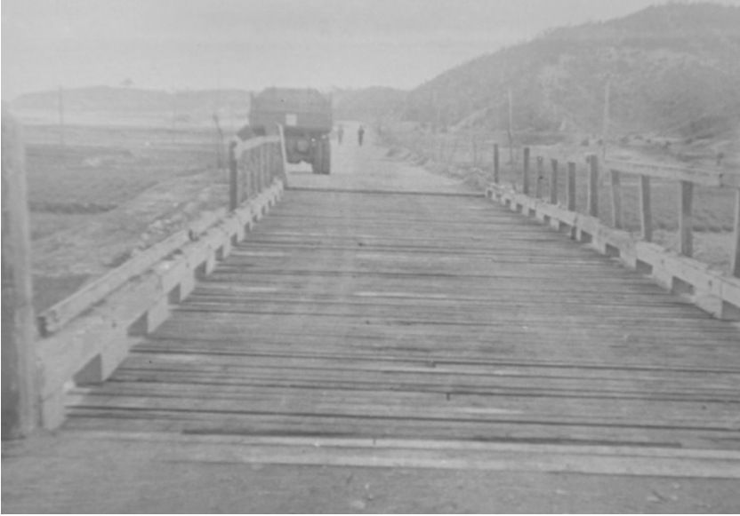
공병단이 2개월만에 완공한 물치쌍천교 (1953)
