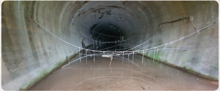
손양면 도화리 터널 내부
