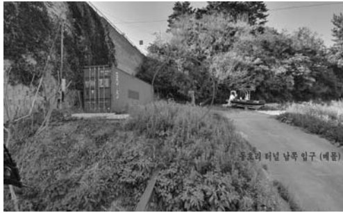
4-2 동호리 동호 터널 (남쪽입구) 매몰
