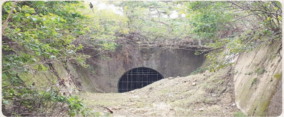
손양면 도화리 터널 (작은굴)
