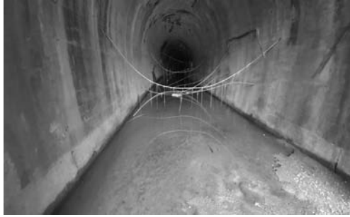
3-3 도화리 터널 내부 (남쪽입구)
