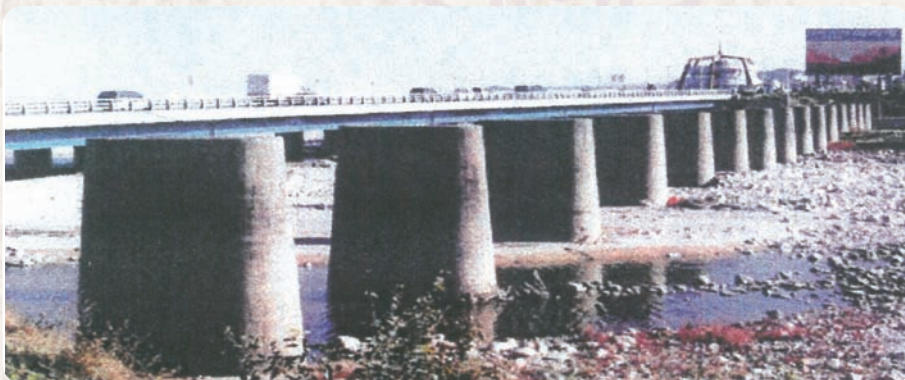
강현면 물치리 쌍천 교각 15개 (2006년 철거)
