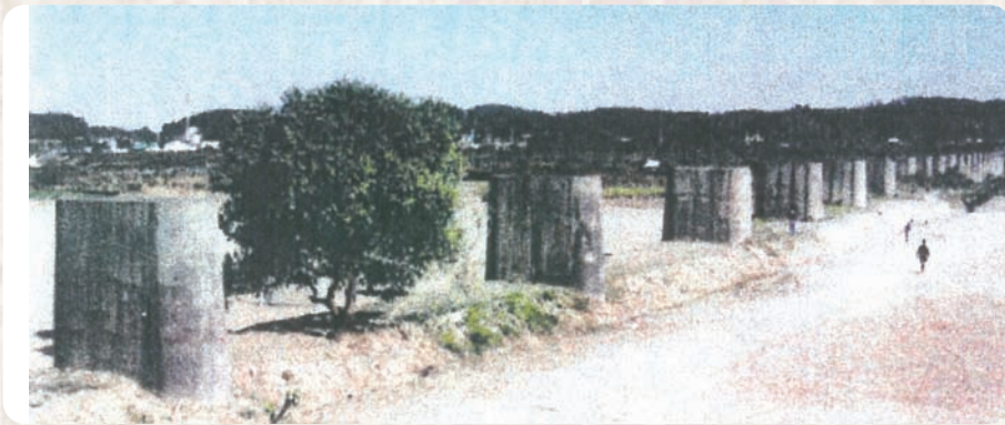
양양읍 연창리 남대전 교각 21개 (2006년 철거)
