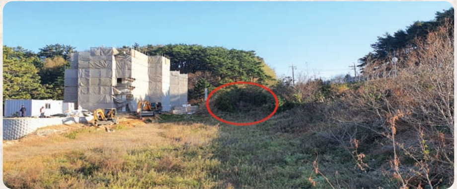
손양면 동호리 터널 (큰굴 : 매몰)
