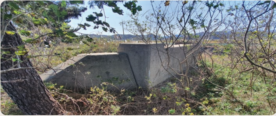
손양면 상운리 여운포천 남쪽 교대
