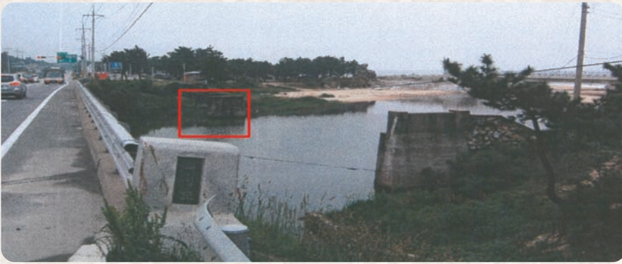
현남면 원포리 화상천 교각 (2006년 철거)
