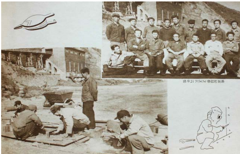
〈사진 4-8〉 공무과 작업 전경(1958년경)
