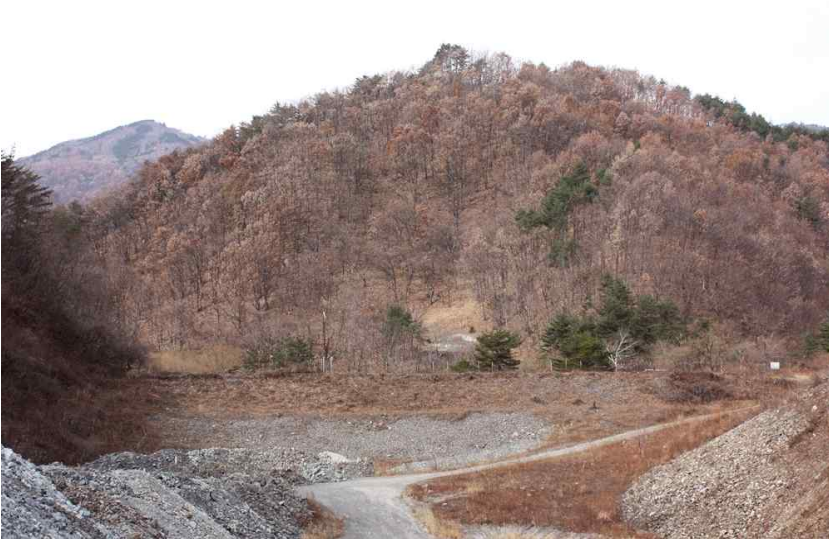
〈사진 29〉 현재 사향골 댐 전경(2012.11)
