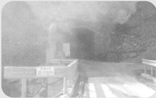
공사 중인 양양댐 (2011년)
