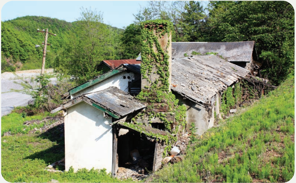
폐광 후 분석실, 노조사무실, 서류창고 (2010. 6. 10)
