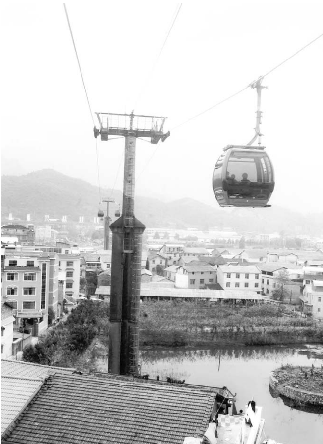
천문선산 석도 주택위로 설치
